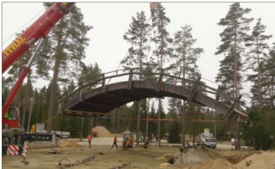
Suusasilla tõstmine uude asukohta. Sild kaalub 13 ja kummagi otsa vundamendiplokk 70 tonni.
